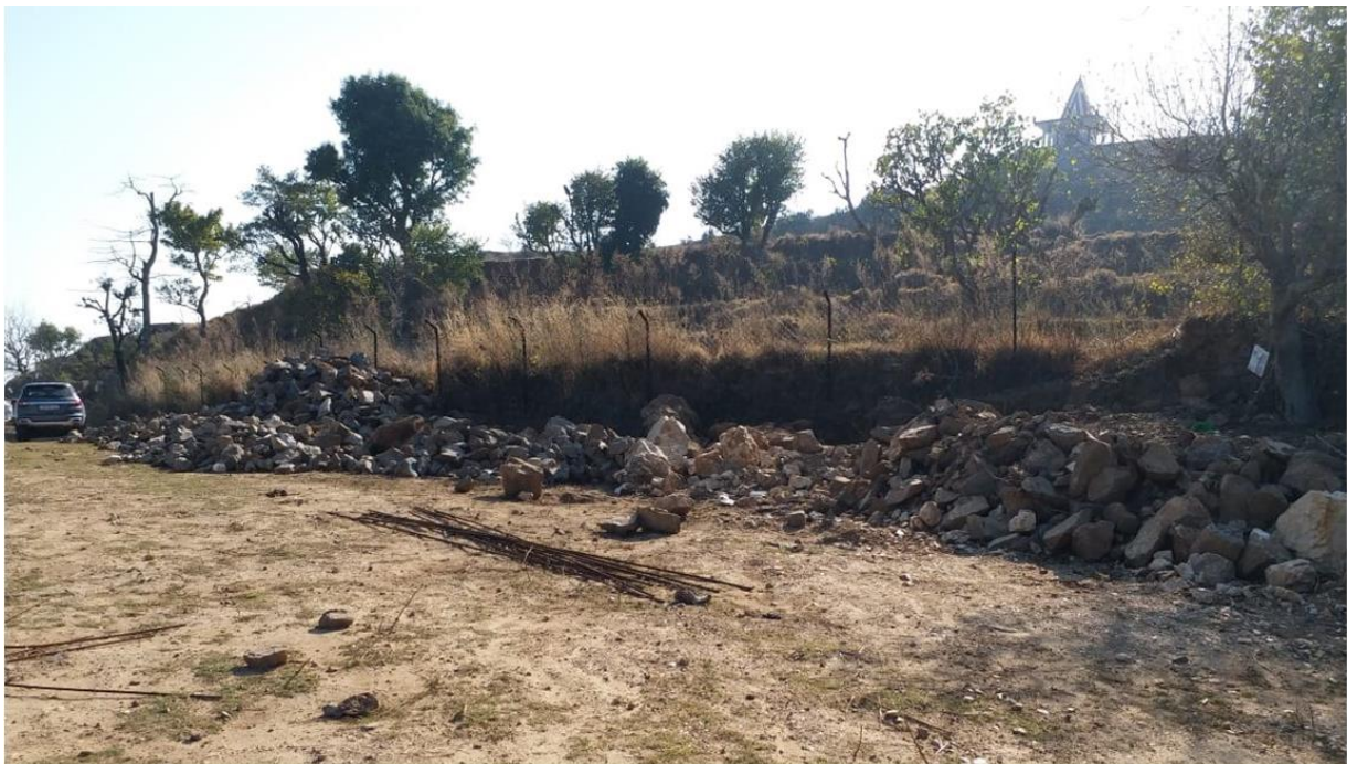
De grond voor de school wordt bouwklaar gemaakt
